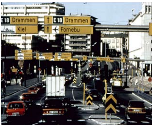
Der Rathausplatz in Oslo vor dem Tunnelbau ... Town Hall Square in Oslo before building the tunnel ...
